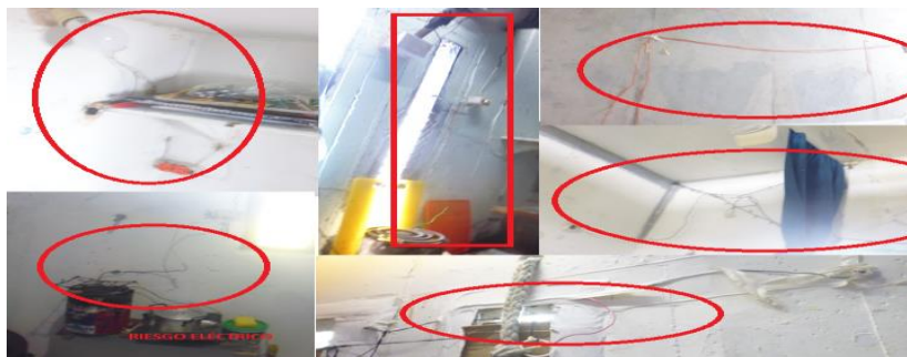
Imagen No. 5- Conexiones hechizas en celdas
